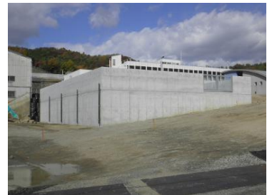
中部浄水場ポンプ井築造工 事
