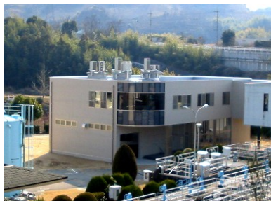
綾川浄水場管理本館
