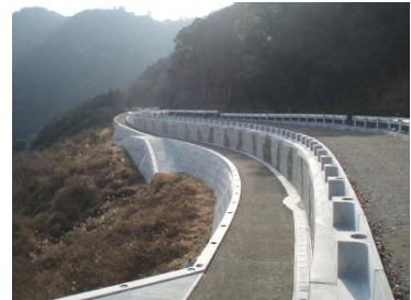
県道鴨川停車場五色台線 道路改築工事
