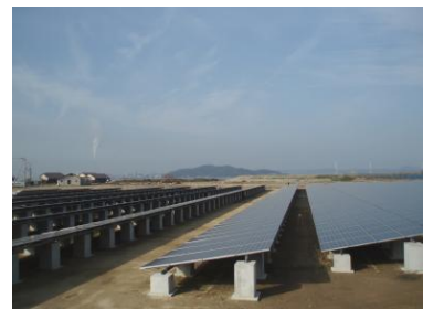
松寿会ソーラー発電所建設 工事
